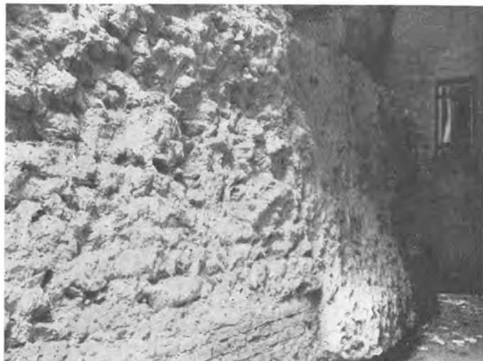
Fig. 34. QUIR. E I . Fronte interna; particolare del nucleo cementizio.
