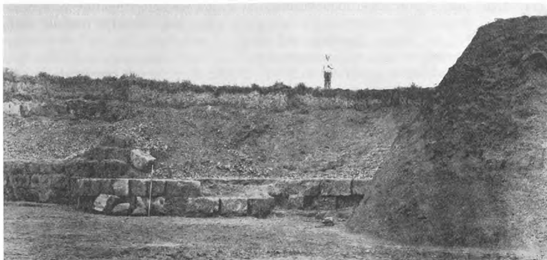
Fig. 21. AGGER E. Fronte interna con resti dell'agger primitivo retrostante. (Parker.)
