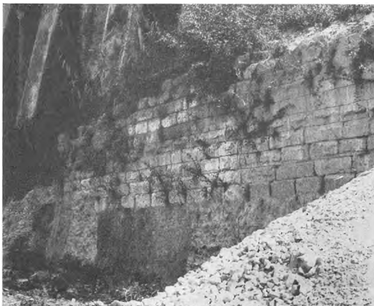
Fig. 33. QUIR. E I . Fronte esterna. Da una fotografia, presa durante gli scavi. (Gabin. Fot. — LUCE.)
