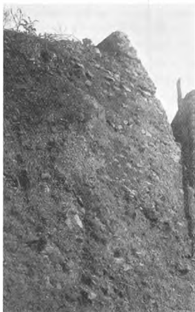
Fig. 13. Av. E. Particolare del terrapieno con il rincalzo concretizio.
