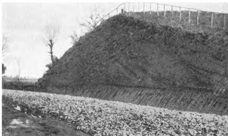
Fig. 60. Particolare dell' agger di Ardea, veduto da nord-ovest (taglio fatto per la nuova strada di Ariccia). (Fot. Boëthius.)
