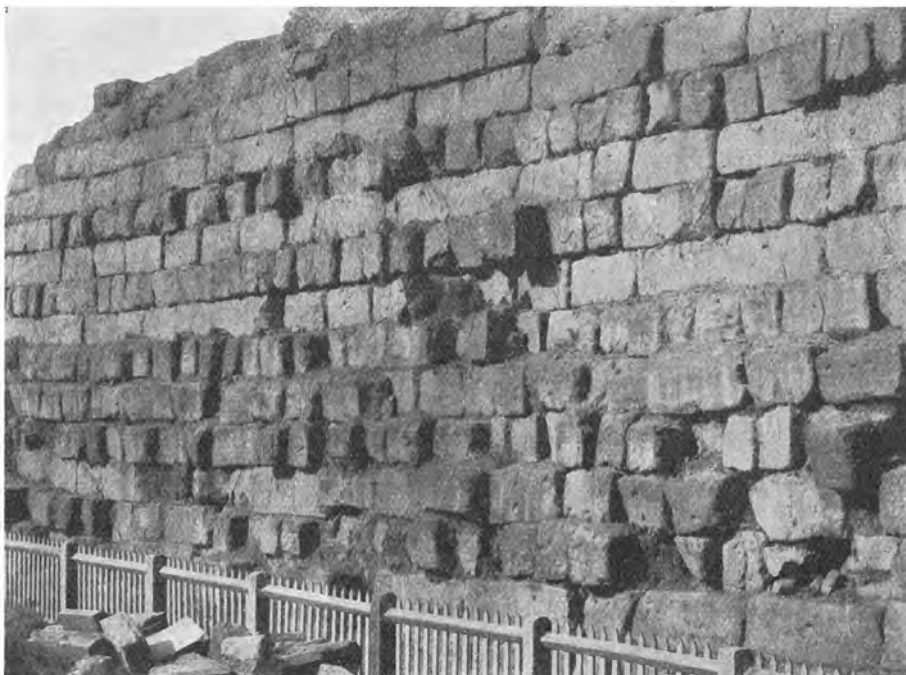
Fig. 25. AGGER K1. Particolare della fronte interna. (Gabin. Fot. — LUCE.)
