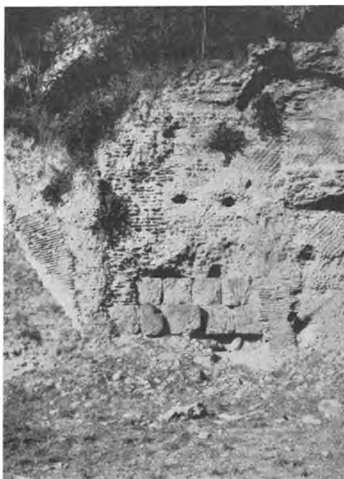
Fig. 4. PAL. D^{II} , veduto da sud-ovest.
