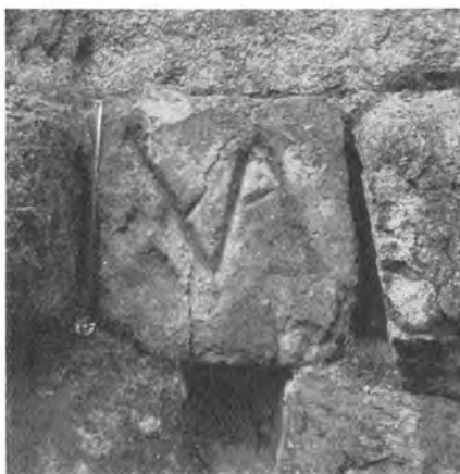
Fig. 52. AGGER K 1 . Marca di cava (n. 54 c).
