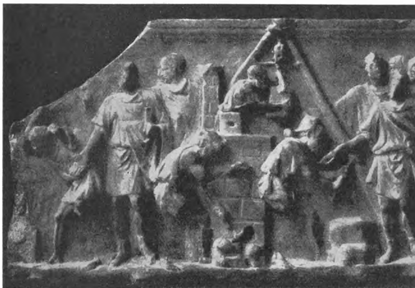
Fig. 57. Costruzione di un muro in opera quadrata: massi manovrati da ferrei forfices ; squadratura e sbazzatura con ascia (nota la sbazzatura dello strato fondamentale già collocato). (Particolare di un bassorilievo di Terracina, raffigurante Traiano che assiste alla costruzione di un porto. Cf. Nuova Antologia 1911, 581.)
