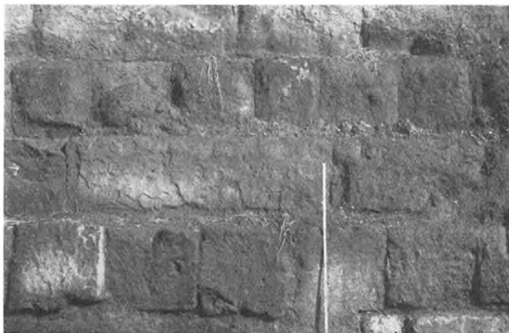
Fig. 7. Av. c. Particolare della fronte esterna.
